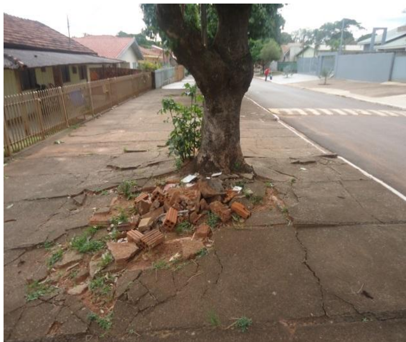
Figura 14 - Covas inadequadas e problemas com o calçamento.
