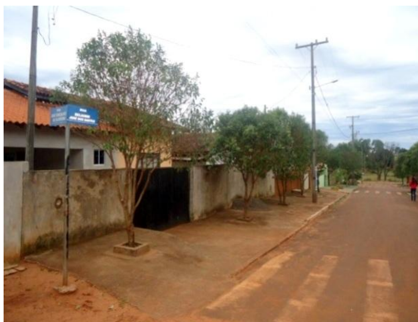
Figura 17 – Problemas de acessibilidade.
