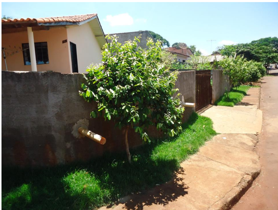
Figura 25 – Árvore muito próxima ao muro
