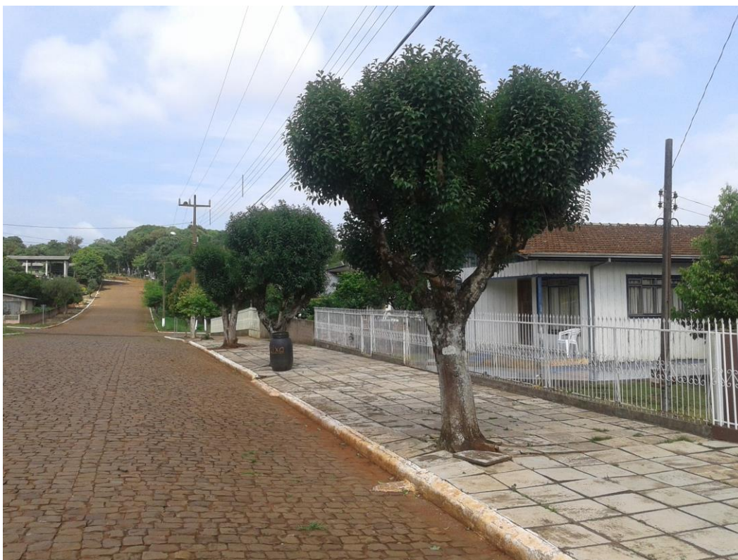
Figura 6 - Ligustro: espécie exótica necessitando poda drástica por estar abaixo da rede de energia
