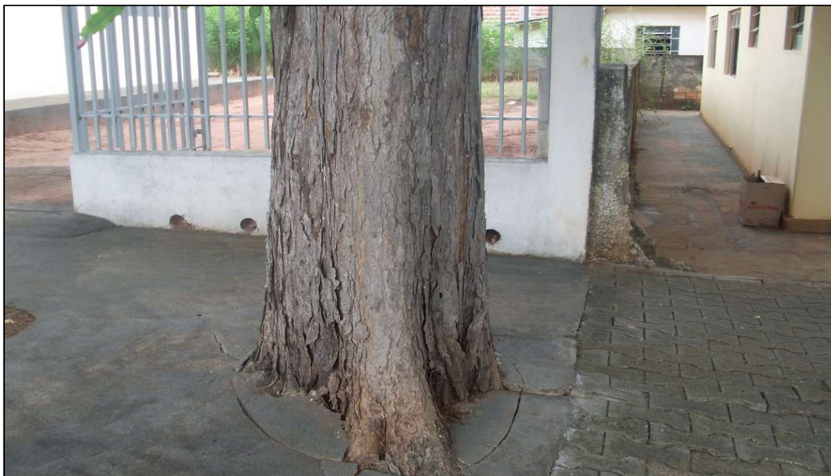
Figura 6. Sibipiruna sem área livre de desenvolvimento danificando a calçada.
