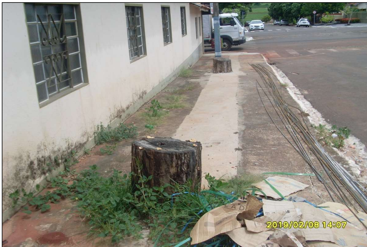
Figura 7. Tocos obstruindo a área livre da calçada.
