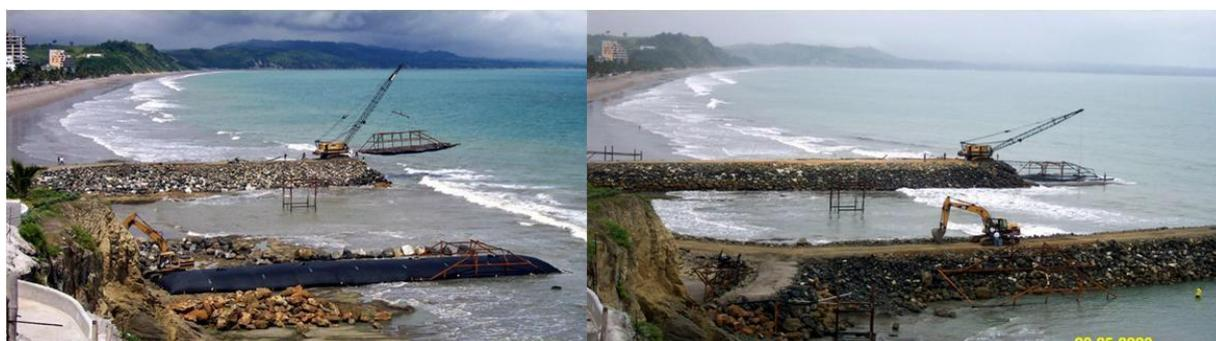
**Figura 3-20: Espigões e diques de contenção de retroárea para construção de marina em Casablanca - Equador**
