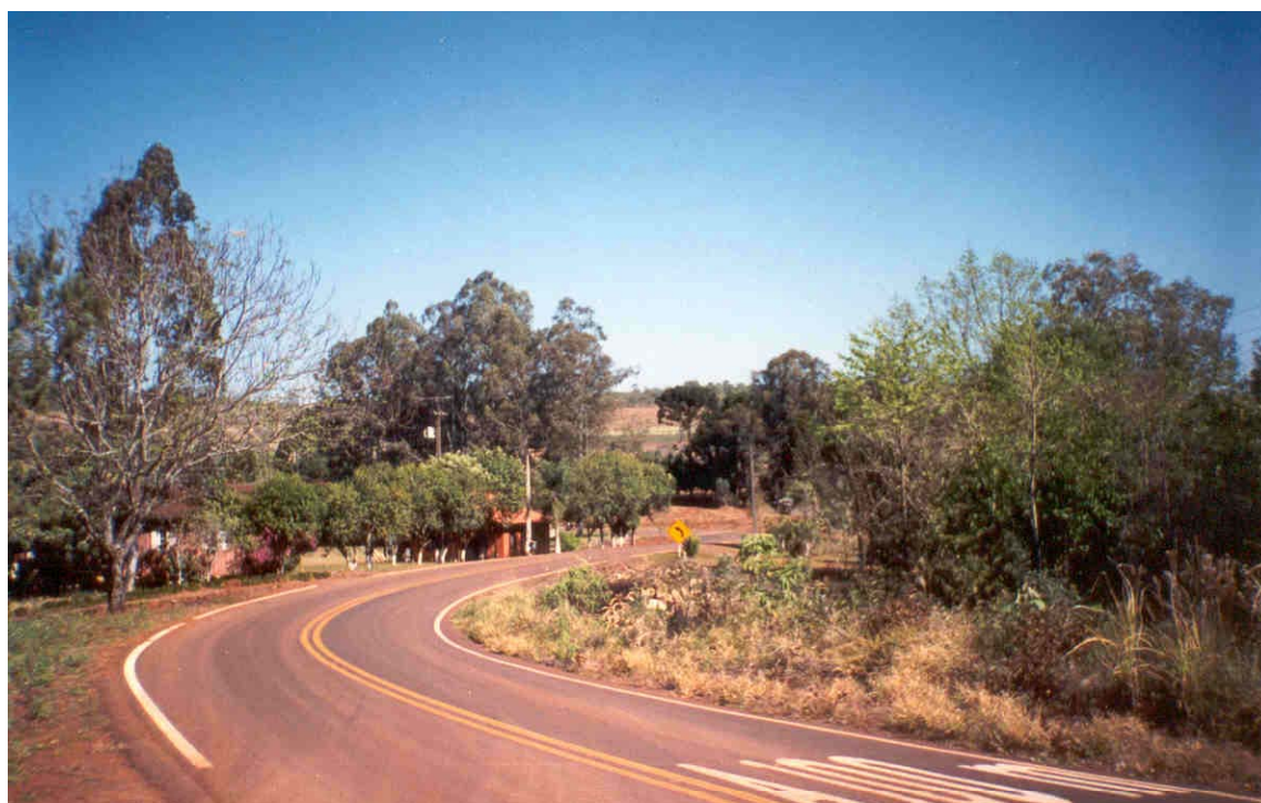
Figura 5.4.4.1 – Aspecto de estradas estaduais do baixo Chopim
