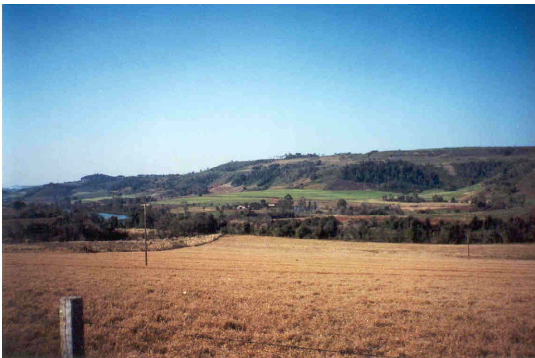
Figura 6.3.3.2.1 – Margens do rio Chopim fortemente descaracterizadas por atividades agrícolas. Região do empreendimento previsto UH Salto Grande.
