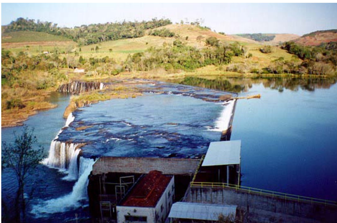
Figura 6.4.6.1 – Usina Chopim I, de propriedade da COPEL
