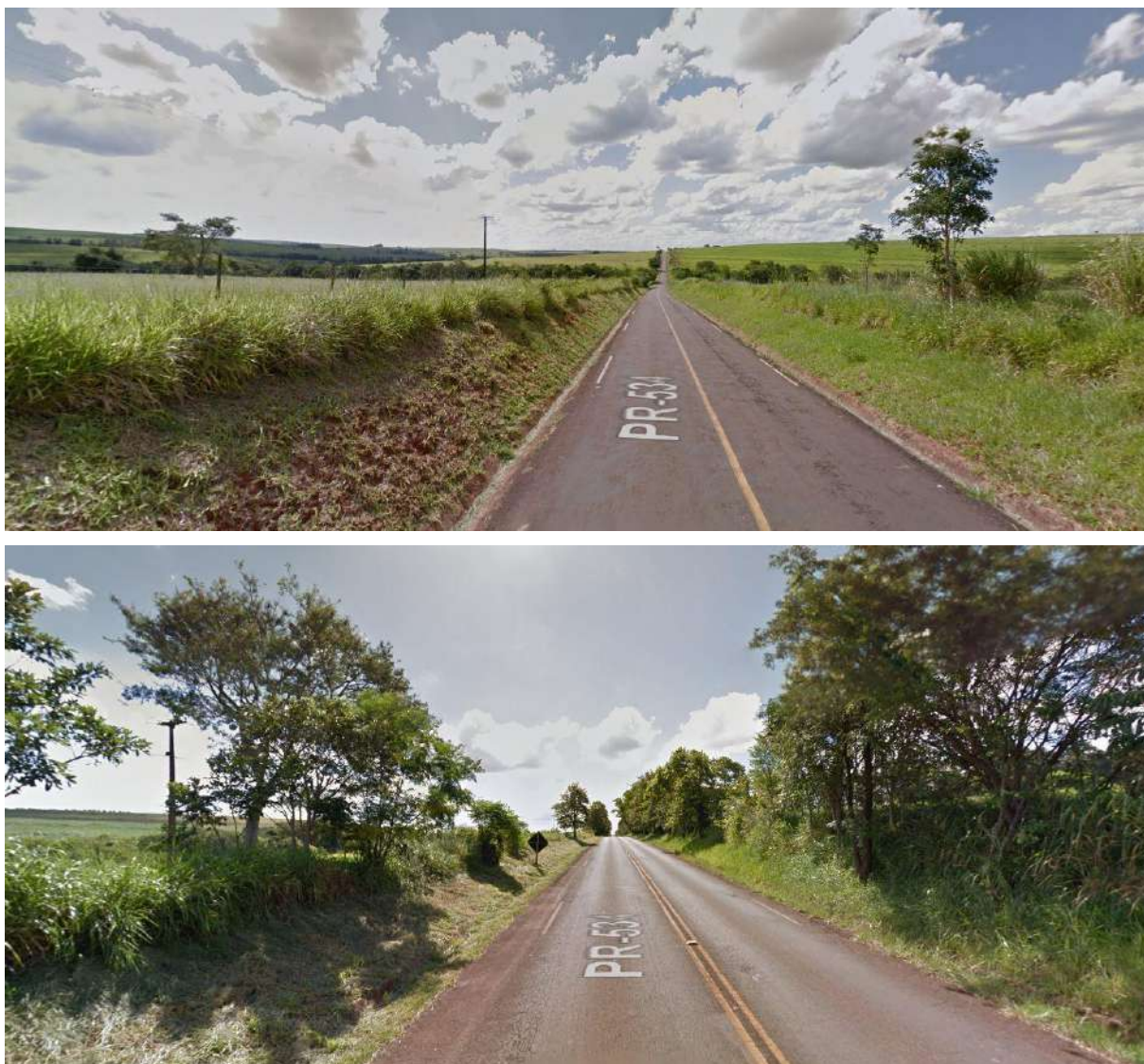
Figura 69 – Imagens de Trechos da PR-534.
