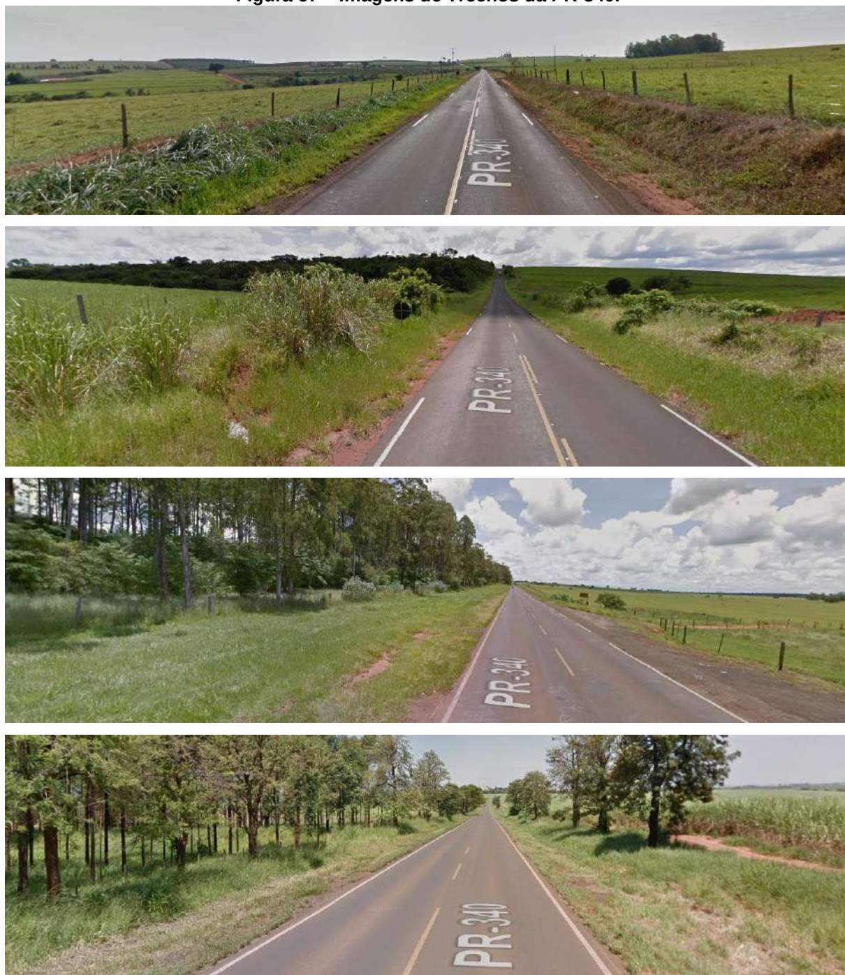
Figura 67 – Imagens de Trechos da PR-340.
