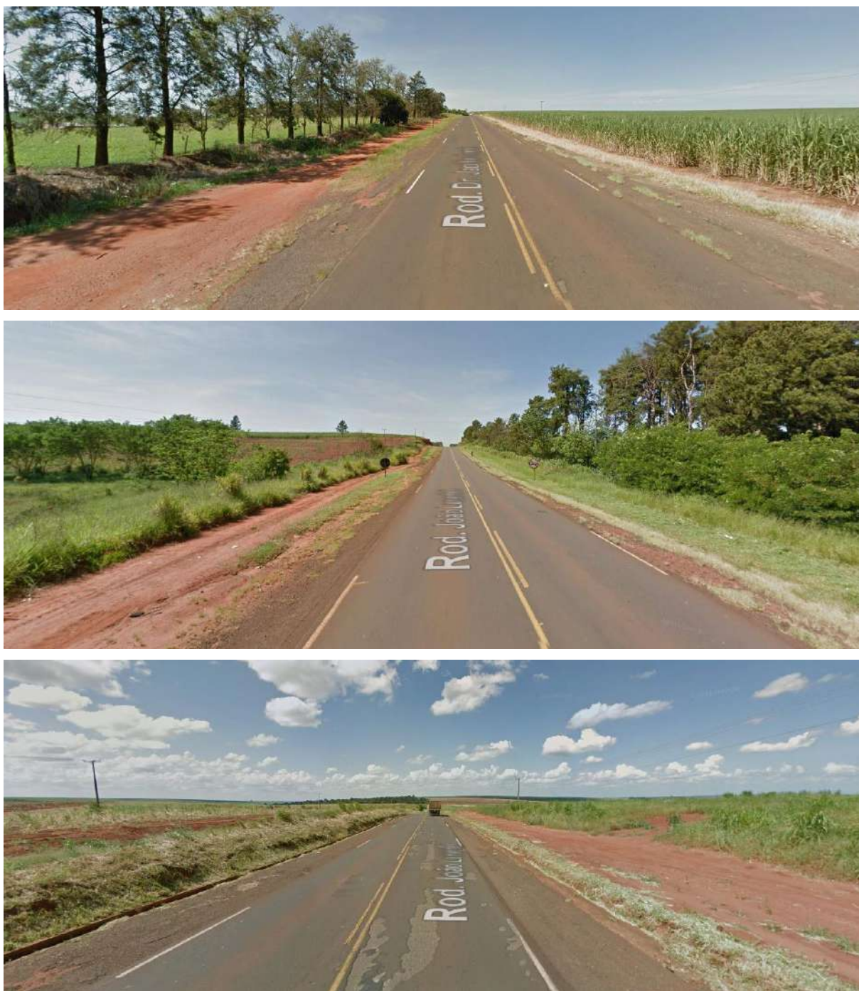
Figura 66 – Imagens de Trechos da PR-170.
