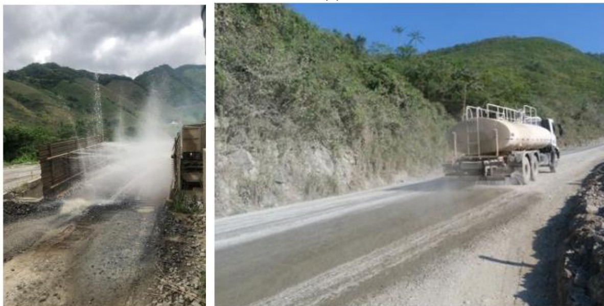
Figura 5 – Novo Lavador de rodas de caminhões e umectação de vias não pavimentadas em execução, com uso de caminhão pipa
