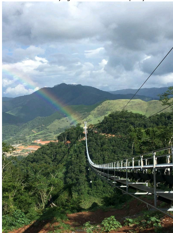
Foto 13 – Flyingbelt instalada e em operação
