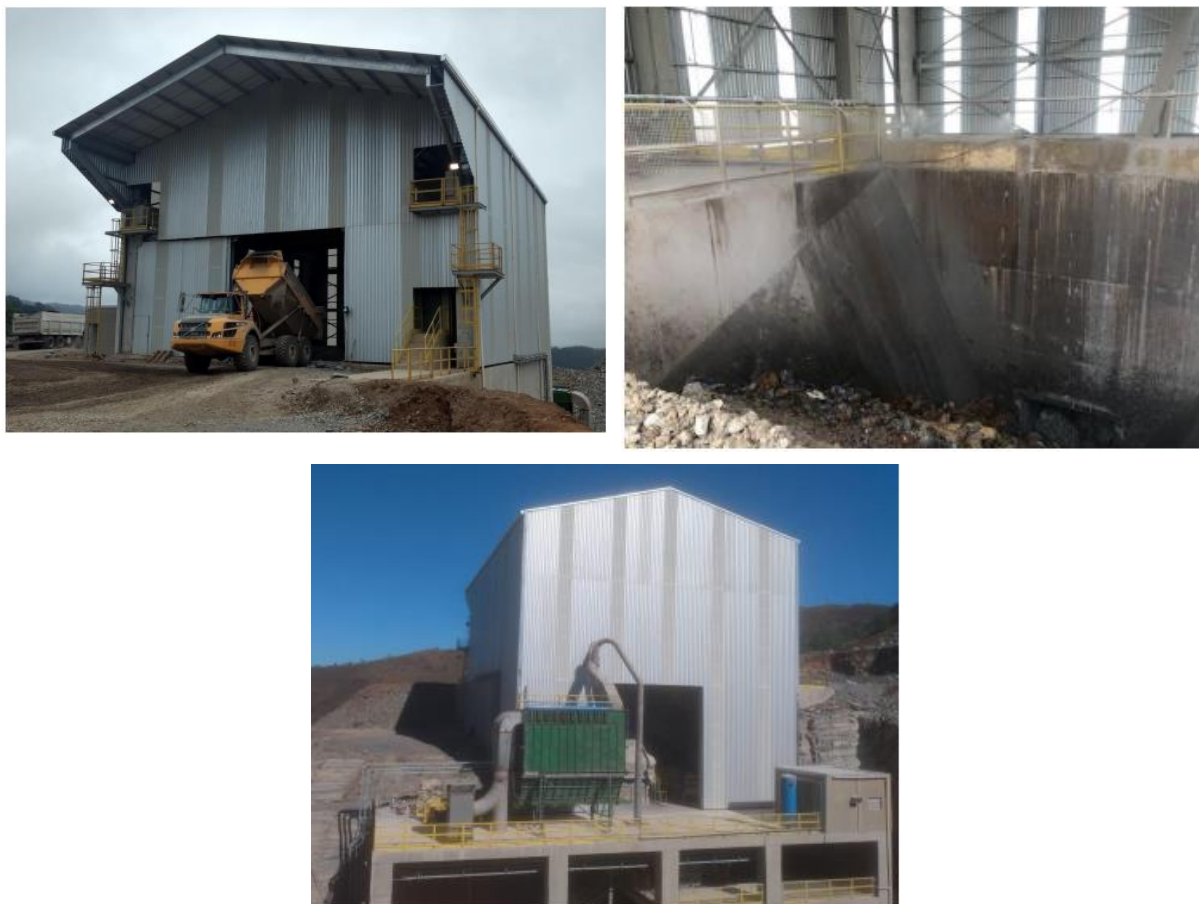
Figura 4 – Britador novo, totalmente fechado; sistema de aspersão de água na moega do britador e filtro de mangas na lateral do britador
