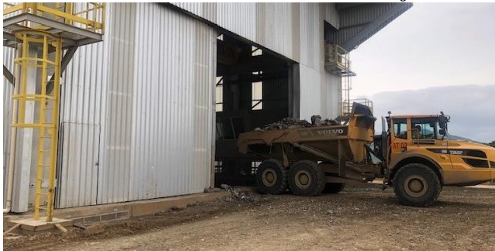
Foto 14 – Detalhe do britador enclausurado e cobertura na área de descarga dos caminhões
