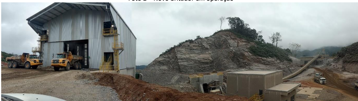
Foto 2 – Novo britador em operação
