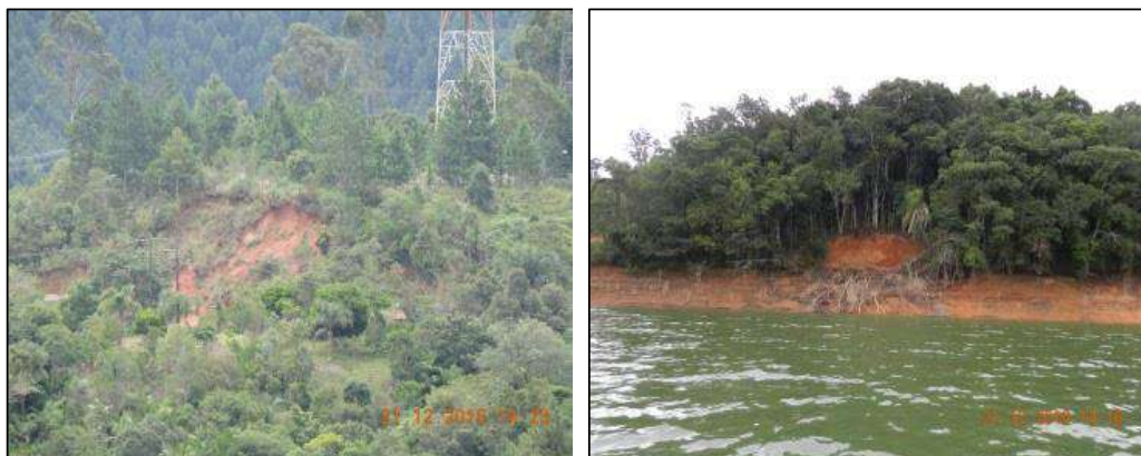
Figura 13. Mosaico dos Processos Erosivos – Bordas e entorno do Reservatórios da UHE Capivari.
