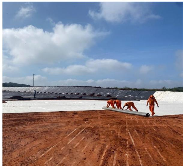
**Figura 8.** Aplicação de PEAD para impermeabilização de base.
