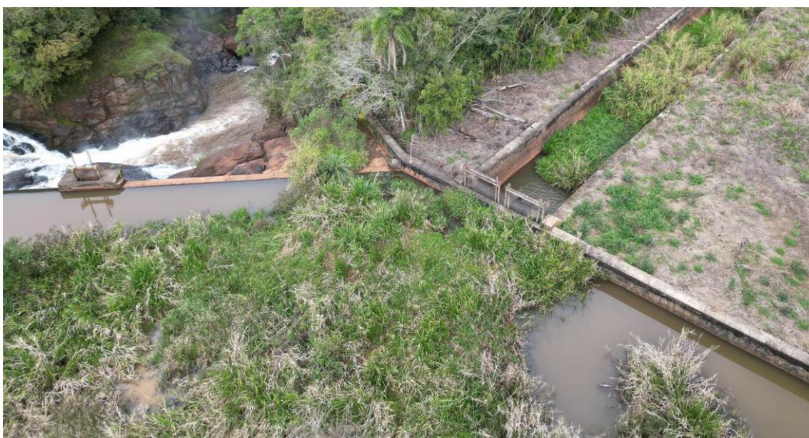
Figura 48 - Vegetação dentro da tomada d'água, parte do reservatório e canal de adução
