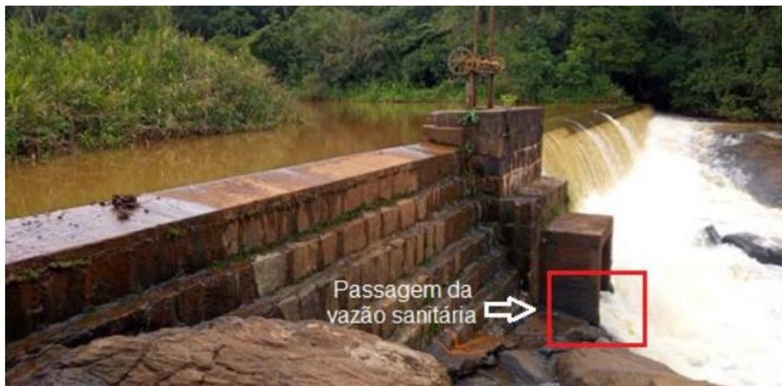
Figura 53 - Passagem da vazão sanitária
