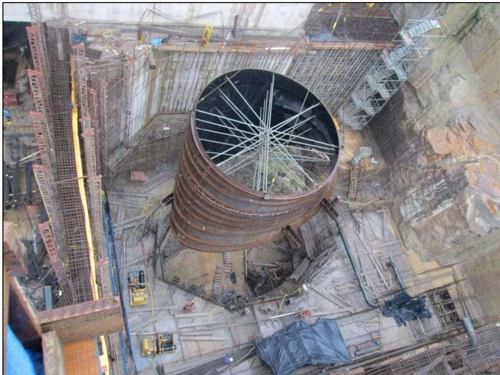
Figura 5-73: Lançamento da blindagem do tubo de sucção.
