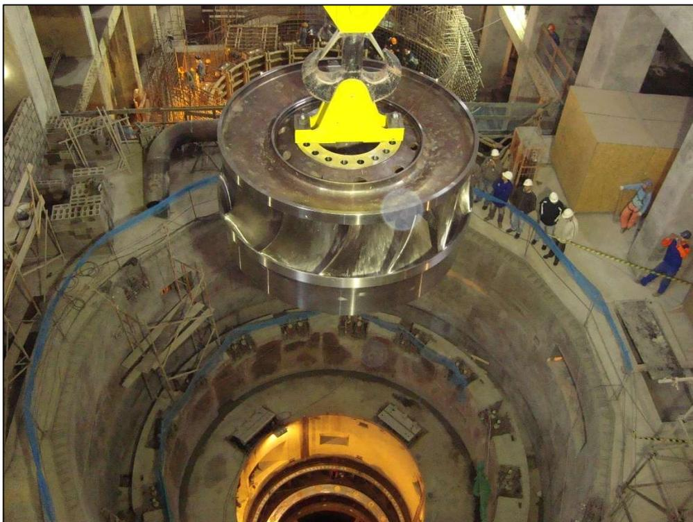
Figura 5-84: Exemplo de lançamento do rotor de uma turbina tipo Francis.
