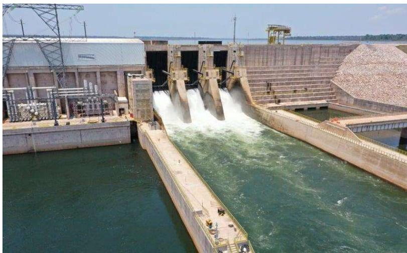
Figura 5-105: À esquerda da imagem, exemplo de subestação compacta instalada junto aos transformadores
