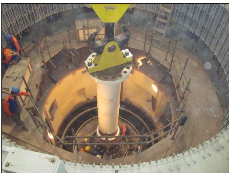
Figura 5-88: Eixo da Turbina no poço
