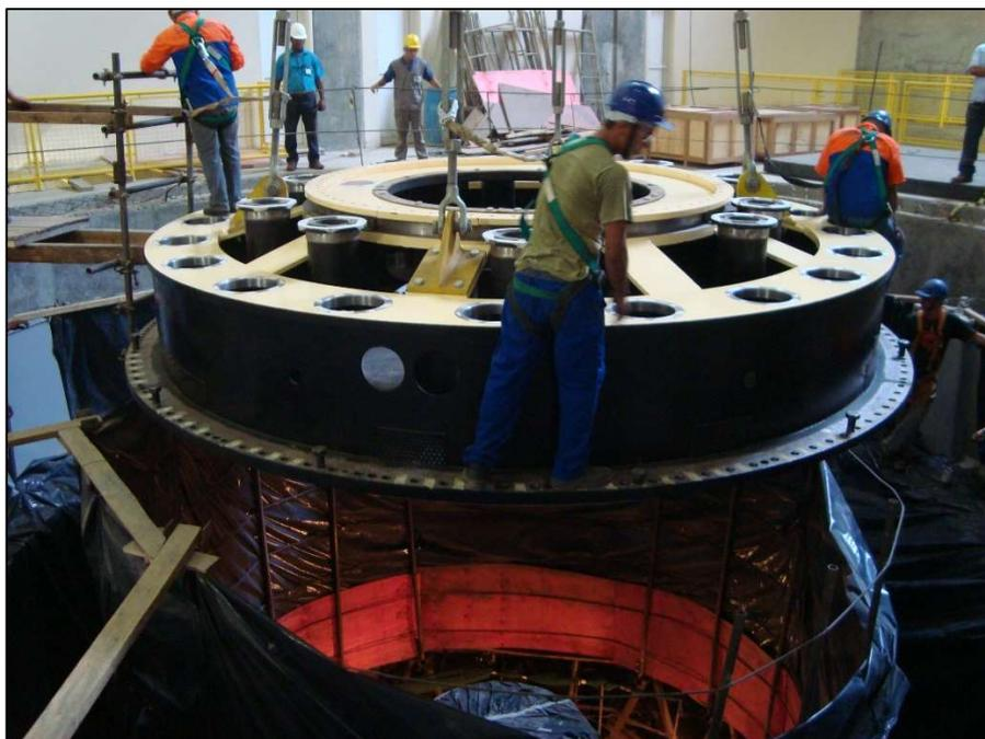
Figura 5-85: Lançamento da tampa da turbina.
