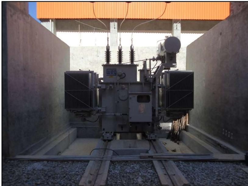
Figura 5-104: Transformador elevador de uma usina hidrelétrica
