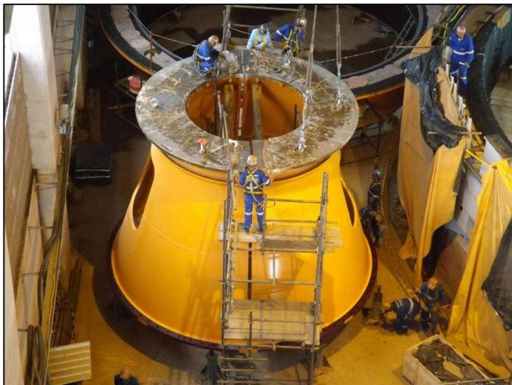
Figura 5-89: Cone suporte na área de montagem.
