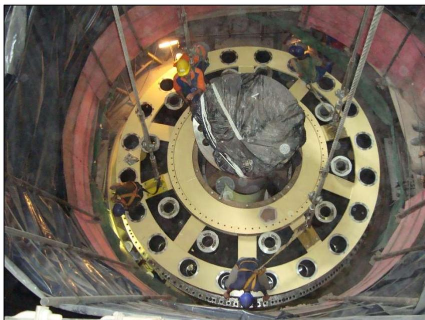
Figura 5-86: Tampa da turbina no poço.
