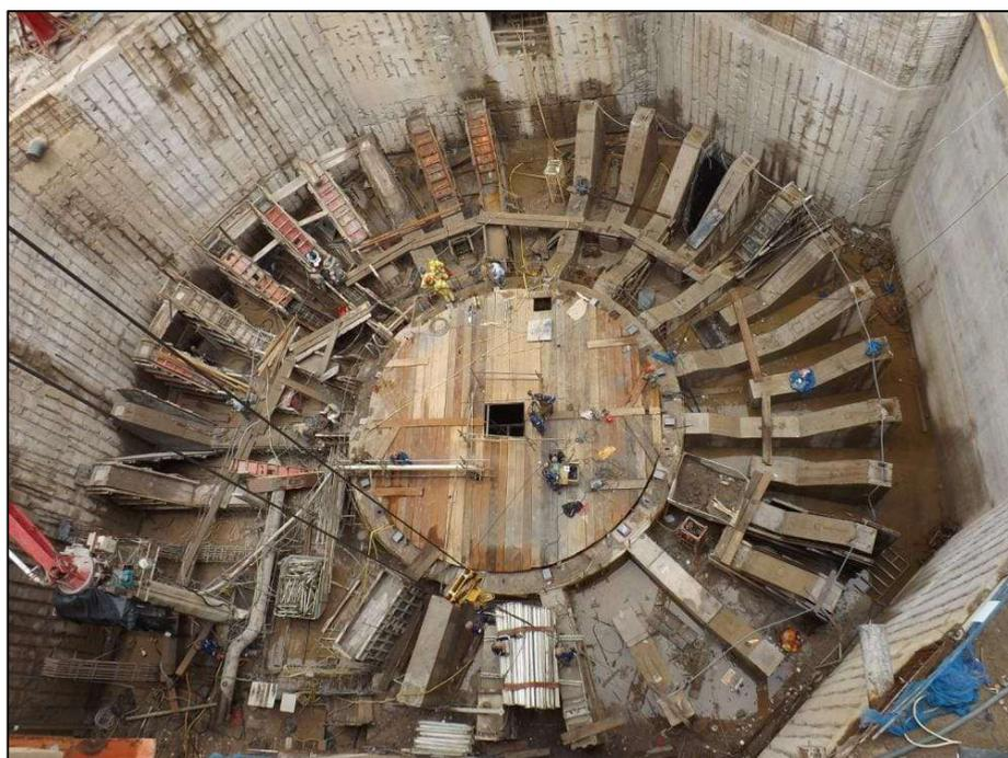
Figura 5-75: Imagem após concretagem da blindagem do tubo de sucção, já com os berços para Caixa Espiral
