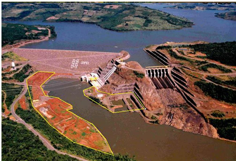
Figura 5-50: Imagem aérea do canteiro industrial da UHE GNB após desmobilização (primeira semindicação da localização do canteiro e depois com a indicação aproximada do canteiro).
