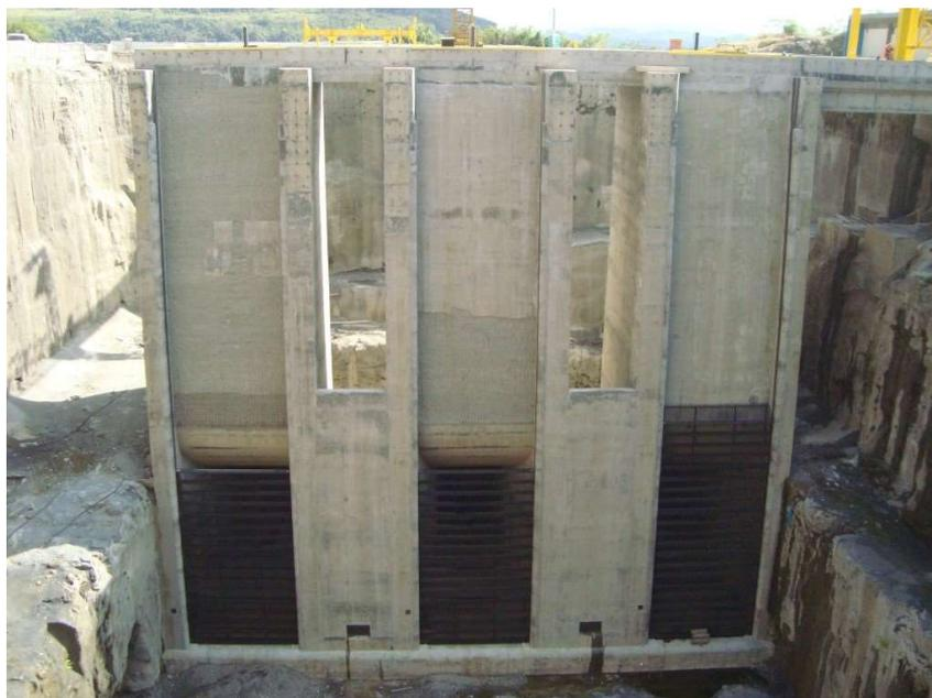
Figura 5-97: Exemplo de grades instaladas em uma tomada d'água
