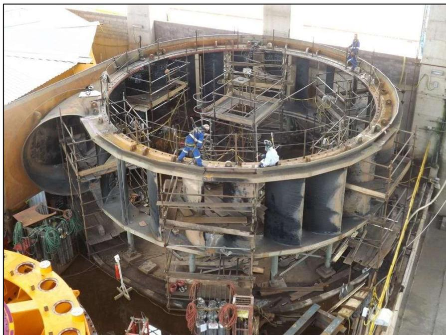
Figura 5-76: Montagem do pré-distribuidor na área de montagem.
