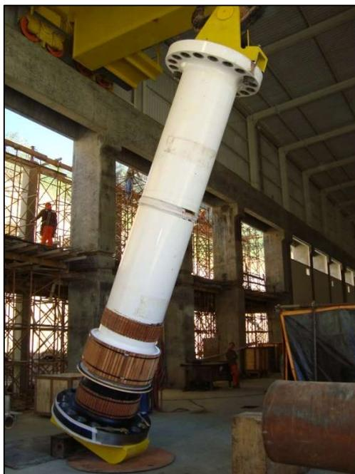
Figura 5-87: Eixo da Turbina na área de montagem.
