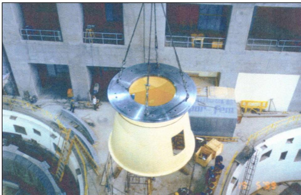
Figura 5-90: Lançamento do Cone Suporte.
