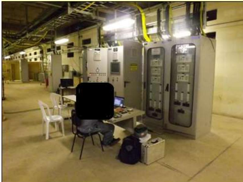
Figura 5-107: Comissionamento dos painéis de proteção.
