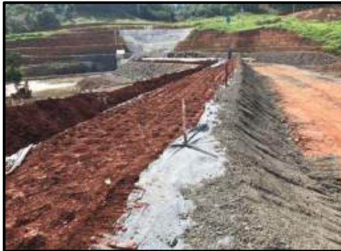
**Figura 26 – Barragem em Execução – Exemplo de Núcleo de Argila com filtros – Acervo da Projetista**
