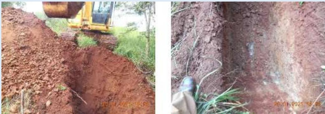
Figura 106 – Registro da execução do poço de inspeção IT-43
