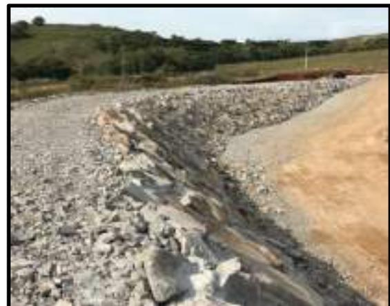
Figura 25 - B - Barragem em Operação – Exemplo de Rip-Rap de Proteção – Acervo da Projetista
