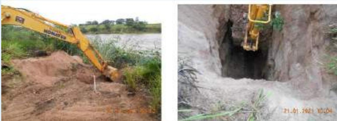
Figura 99 – Registro da execução do poço de inspeção IT-36A
