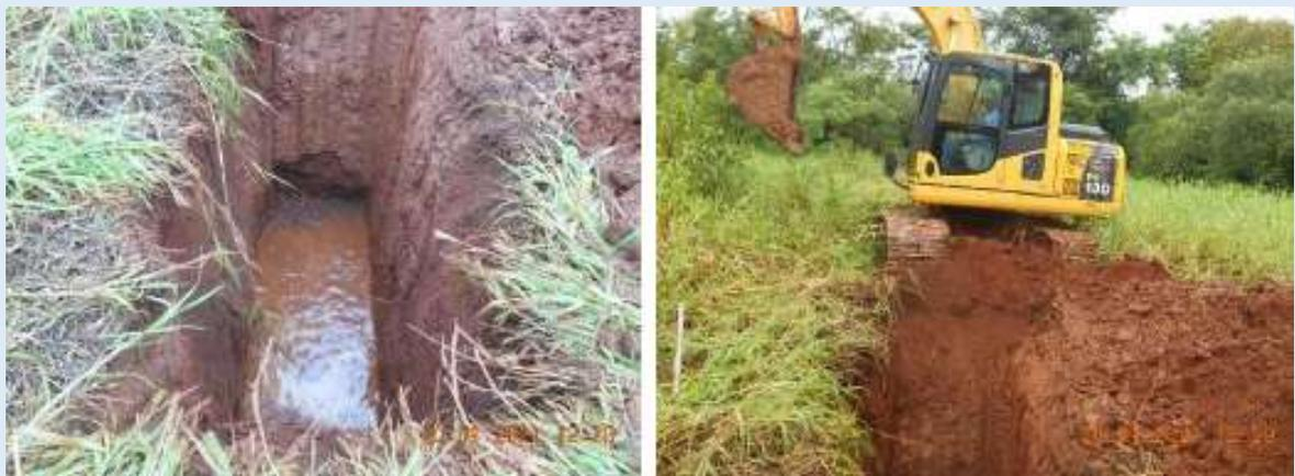
Figura 83 – Registro da execução do poço de inspeção IT-13
