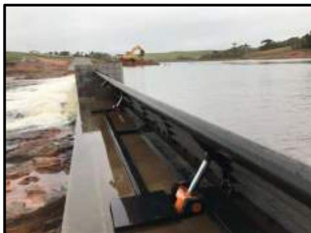
Figura 28 – Exemplo de Vertedor com Comporta Basculante Em Posição “Fechada” – Acervo da Projetista
