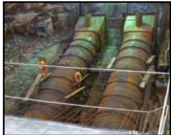
Figura 33 - Exemplo de montagem dos Condutos forçados - Acervo da projetista
