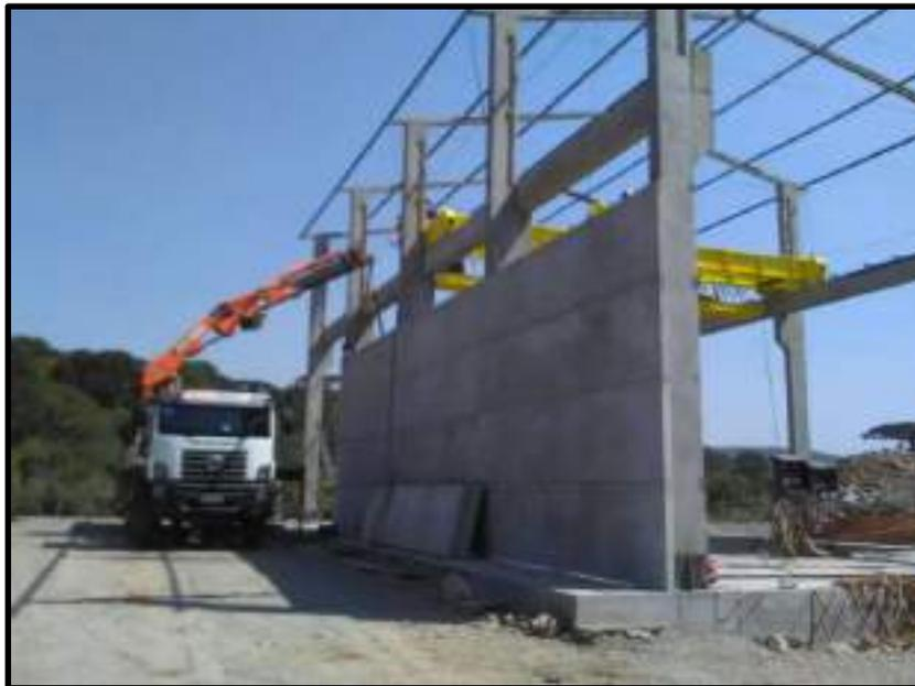
Figura 35 – Exemplo de Inserção das Placas Pré-Moldadas para Fechamento da Superestrutura - Acervo da projetista
