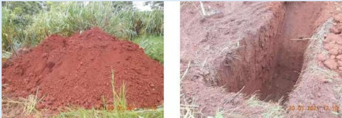
Figura 86 – Registro da execução do poço de inspeção IT-21
