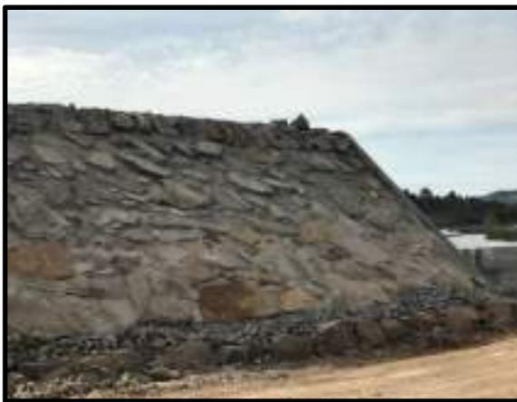
Figura 24 - A - Barragem em Operação – Exemplo de Rip-Rap de Proteção – Acervo da Projetista
