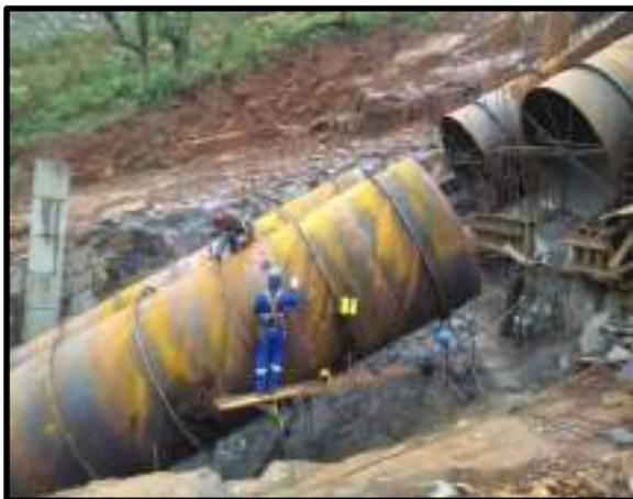
Figura 32 - Exemplo de montagem dos Condutos forçados - Acervo da projetista
