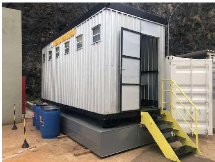
Figura 9-VI: Banheiros Containers com tanque sêptico acoplado
