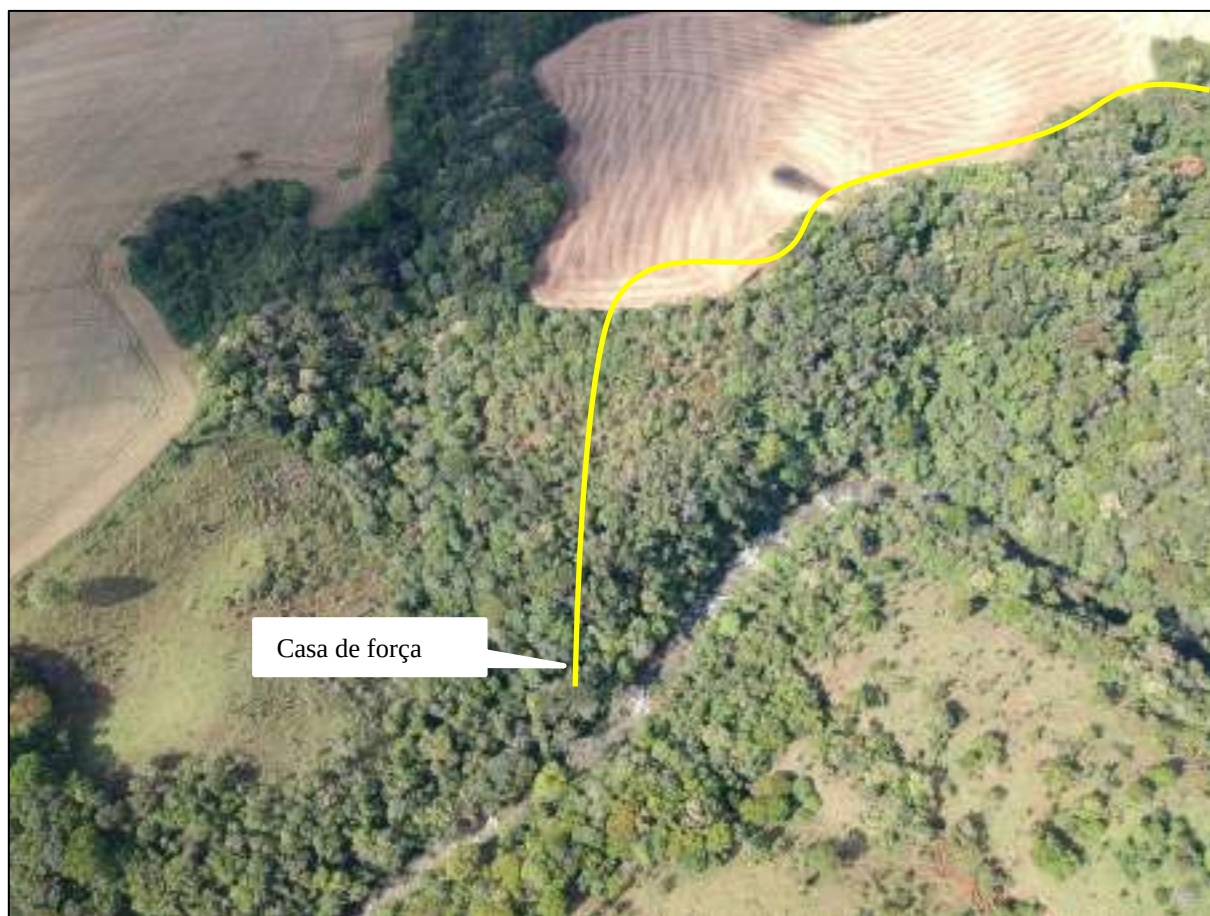
Figura 298: Observação do dossel da vegetação no fragmento do conduto forçado e casa de força.
