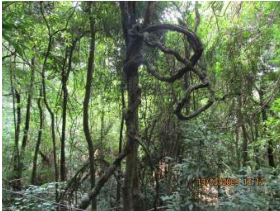
Figura 267: Local de construção da casa de força, poucas lianas.
