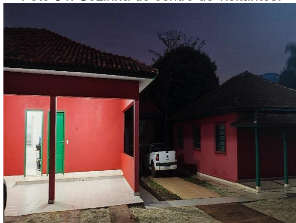
Foto 84. Cozinha do centro de visitantes.
