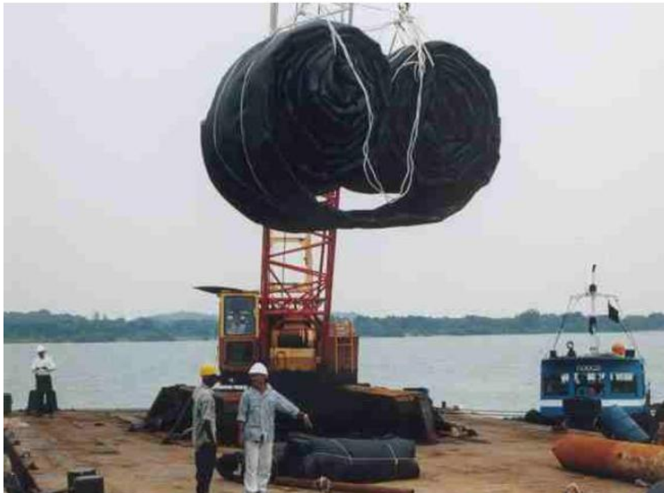
FIGURA 115 – PREPARAÇÃO DA ÁREA PARA INSTALAÇÃO DO GEOTUBO TÊXTIL DE ALTA DENSIDADE.
