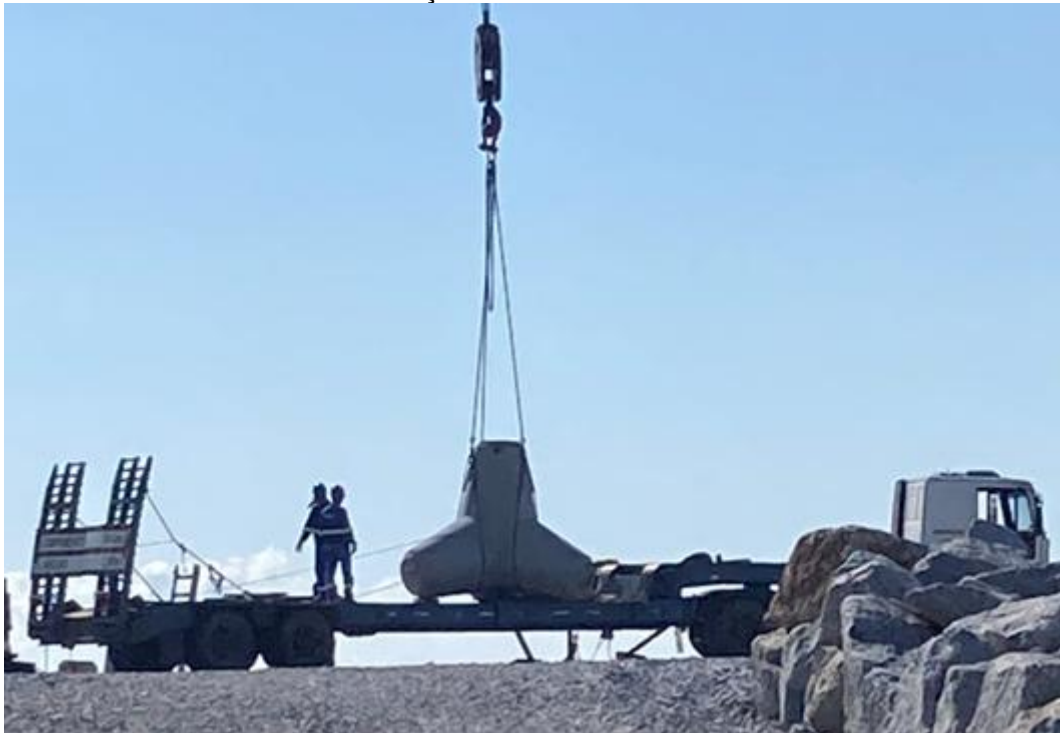
FIGURA 117 – GUINDASTE SOBRE ESTEIRAS PARA COLOCAÇÃO DE PEÇA DE CONCRETO NA CARAPAÇA DE GUIA-CORRENTES.
