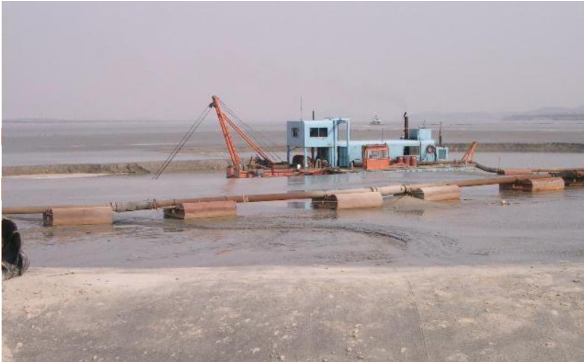
FIGURA 116 – DRAGA POSICIONADA PARA RECALQUE DE EMULSÃO (ÁGUA + AREIA) PARA AS UNIDADES GEOTUBO TÊXTIL DE ALTA DENSIDADE.
