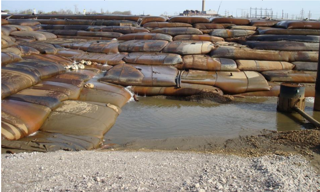
FIGURA 103 – PROCESSO DE DESAGUAMENTO DE SEDIMENTOS CONTAMINADOS EM QUE O EMPILHAMENTO FINAL RESULTOU EM 11 CAMADAS DE UNIDADES GEOTUBO TÊXTIL DE ALTA DENSIDADE (FOTO TIRADA EM ASHTABULA, OHIO, EUA).
