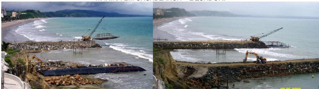
FIGURA 114 – ESPIGÕES E DIQUES DE CONTENÇÃO DE RETROÁREA PARA CONSTRUÇÃO DE MARINA EM CASABLANCA – EQUADOR.
