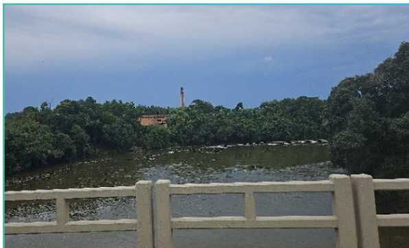
Ponte sobre o rio Iguaçu, a oeste do traçado do empreendimento.
