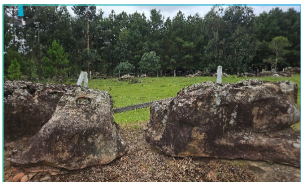
Afloramentos de arenito na porção norte da área de influência direta do empreendimento, próxima ao Seccionamento da LT 525 kV Bateias – Ponta Grossa C1 na SE Curitiba Oeste
