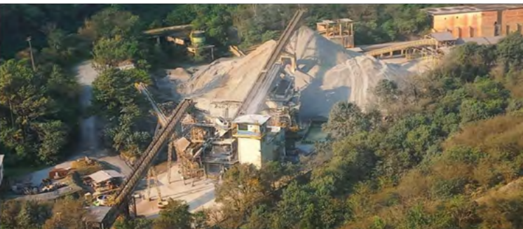
FOTO 3.10 Vista geral das instalações de britagem da Mina Itaretama.
