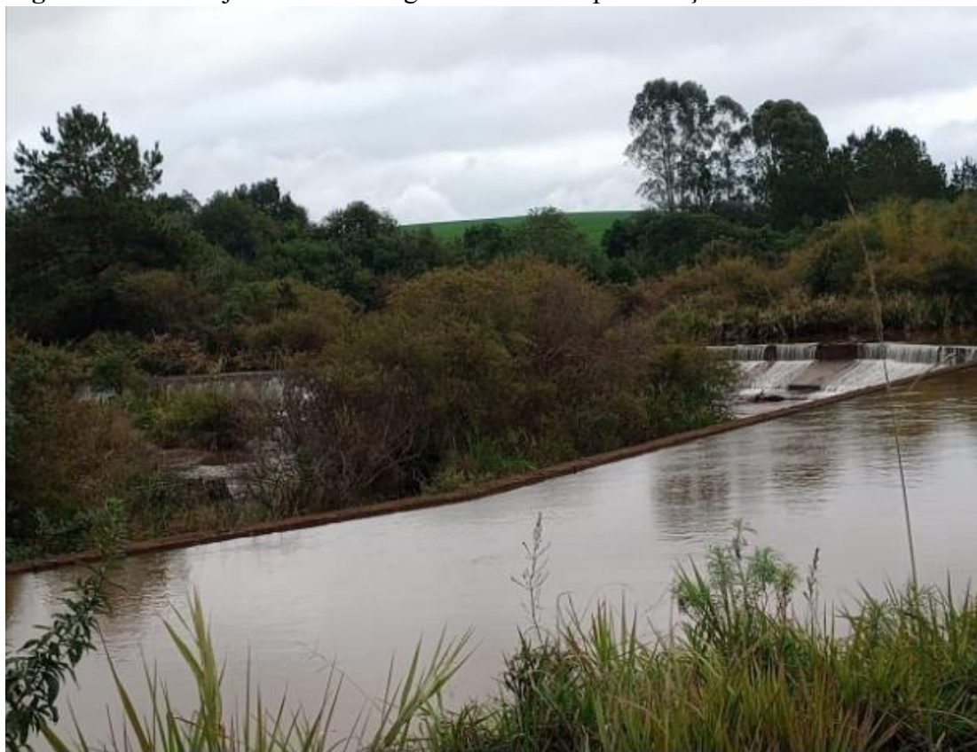
Figura 2. Vista de jusante da barragem e canal de aproximação do circuito adutor.
