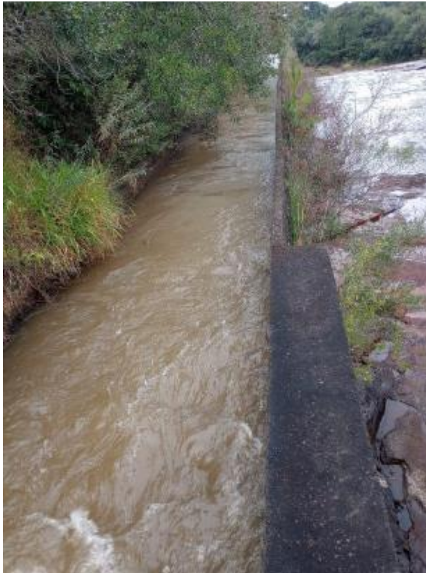
Figura 3. Canal Adutor – vista de montante para jusante, Barragem Candói.
