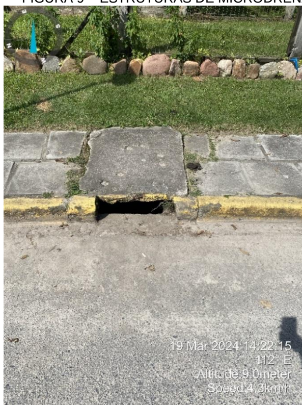
FIGURA 9 – ESTRUTURAS DE MICRODRENAGEM NAS ADJACÊNCIAS DA ORLA DE CAIEIRAS
