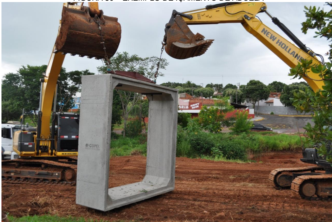
FIGURA 36 – EXEMPLO DE IÇAMENTO DE ADUELA
