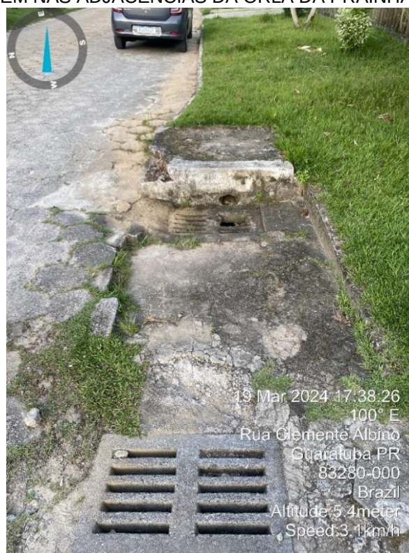
FIGURA 13 – ESTRUTURAS DE MICRODRENAGEM NAS ADJACÊNCIAS DA ORLA DA PRAINHA
