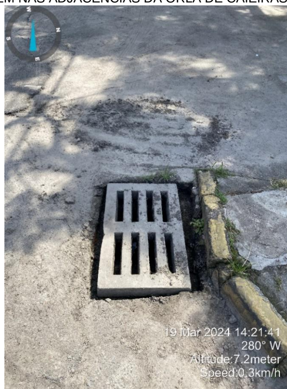
FIGURA 9 – ESTRUTURAS DE MICRODRENAGEM NAS ADJACÊNCIAS DA ORLA DE CAIEIRAS
