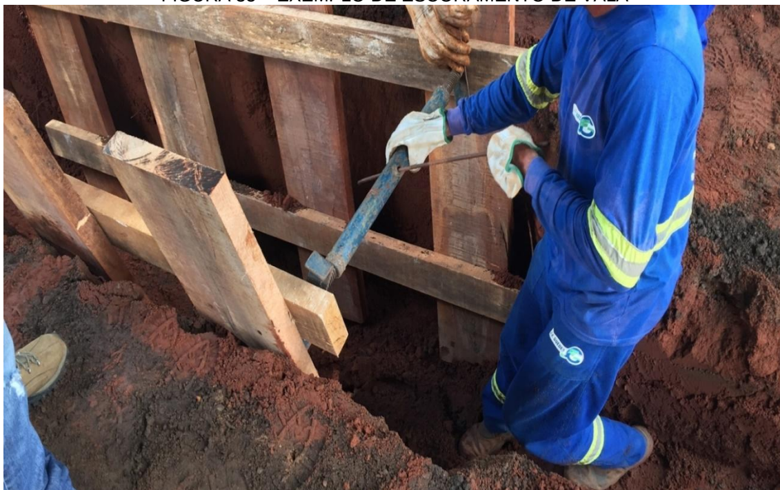
FIGURA 35 – EXEMPLO DE ESCORAMENTO DE VALA
