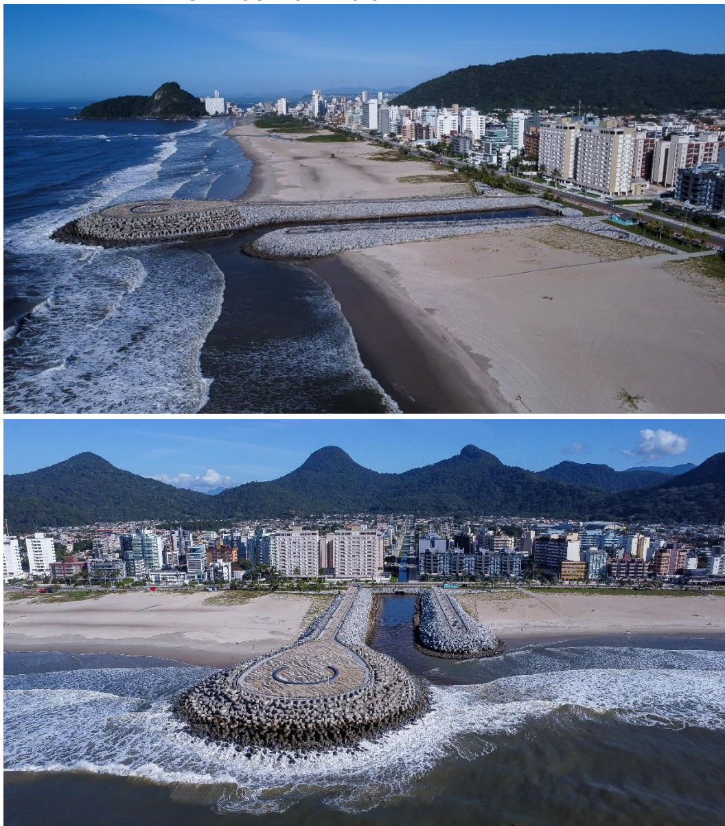
FIGURA 120 – PAR DE GUIAS-CORRENTES IMPLANTADO NA PRAIA DE MATINHOS-PR, NA DESEMBOCADURA DO CANAL DA AV. PARANÁ
