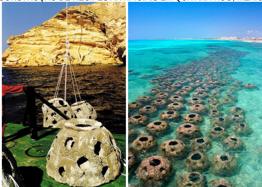
FIGURA 116 – ESTRUTURAS ARTIFICIAIS DO TIPO “REEF BALL” UTILIZADAS PARA CONSTRUÇÃO DE RECIFES ARTIFICIAIS EM QUITANA ROO, MEXICO
