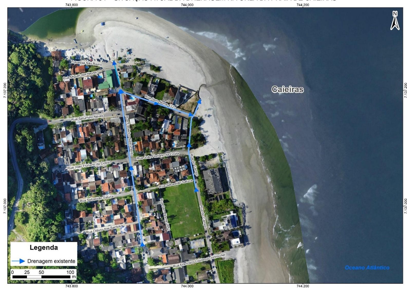
FIGURA 34 – SITUAÇÃO ATUAL DA DRENAGEM NA ORLA DA PRAIA DE CAIEIRAS
