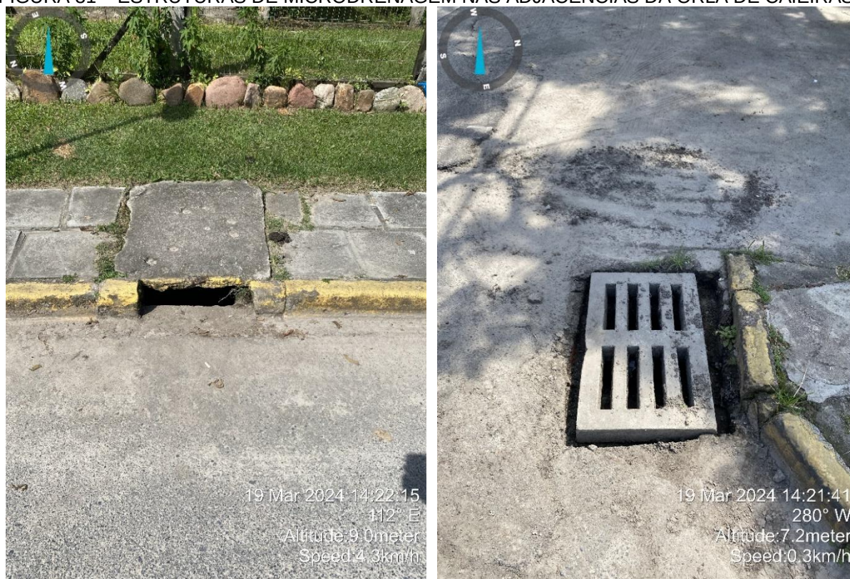
FIGURA 31 – ESTRUTURAS DE MICRODRENAGEM NAS ADJACÊNCIAS DA ORLA DE CAIEIRAS
