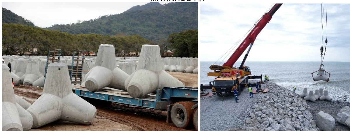
FIGURA 8 – EXEMPLO DE TETRÁPODES, UTILIZADOS NAS OBRAS DE ENGORDAMENTO DE MATINHOS-PR
