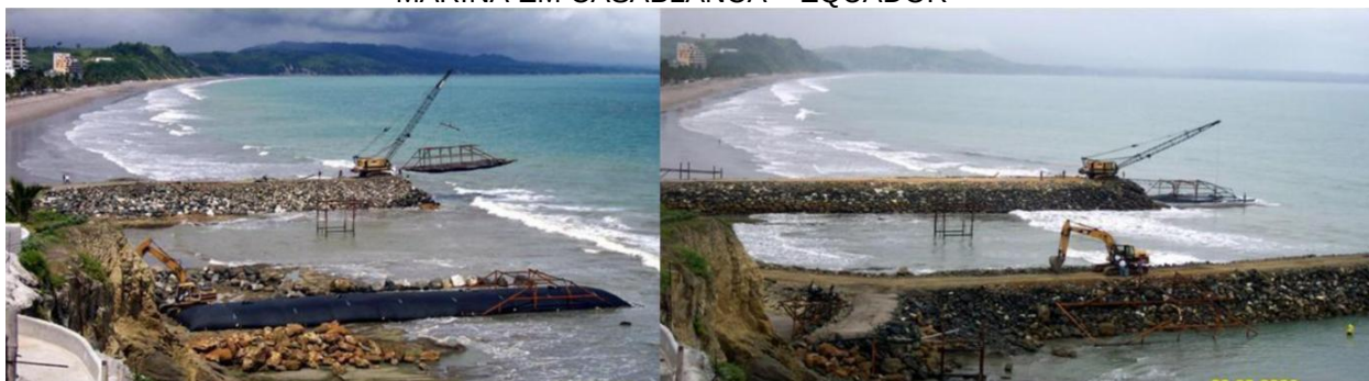
FIGURA 11 – ESPIGÕES E DIQUES DE CONTENÇÃO DE RETROÁREA PARA CONSTRUÇÃO DE MARINA EM CASABLANCA – EQUADOR
