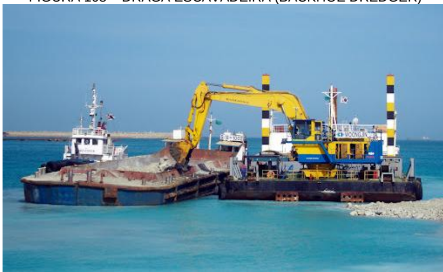
FIGURA 108 – DRAGA ESCAVADEIRA (BACKHOE DREDGER)
