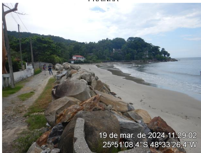
FIGURA 48 – ENROCAMENTO SEPARANDO A AV. BEIRA MAR E A FAIXA DE AREIA DA PRAINHA
