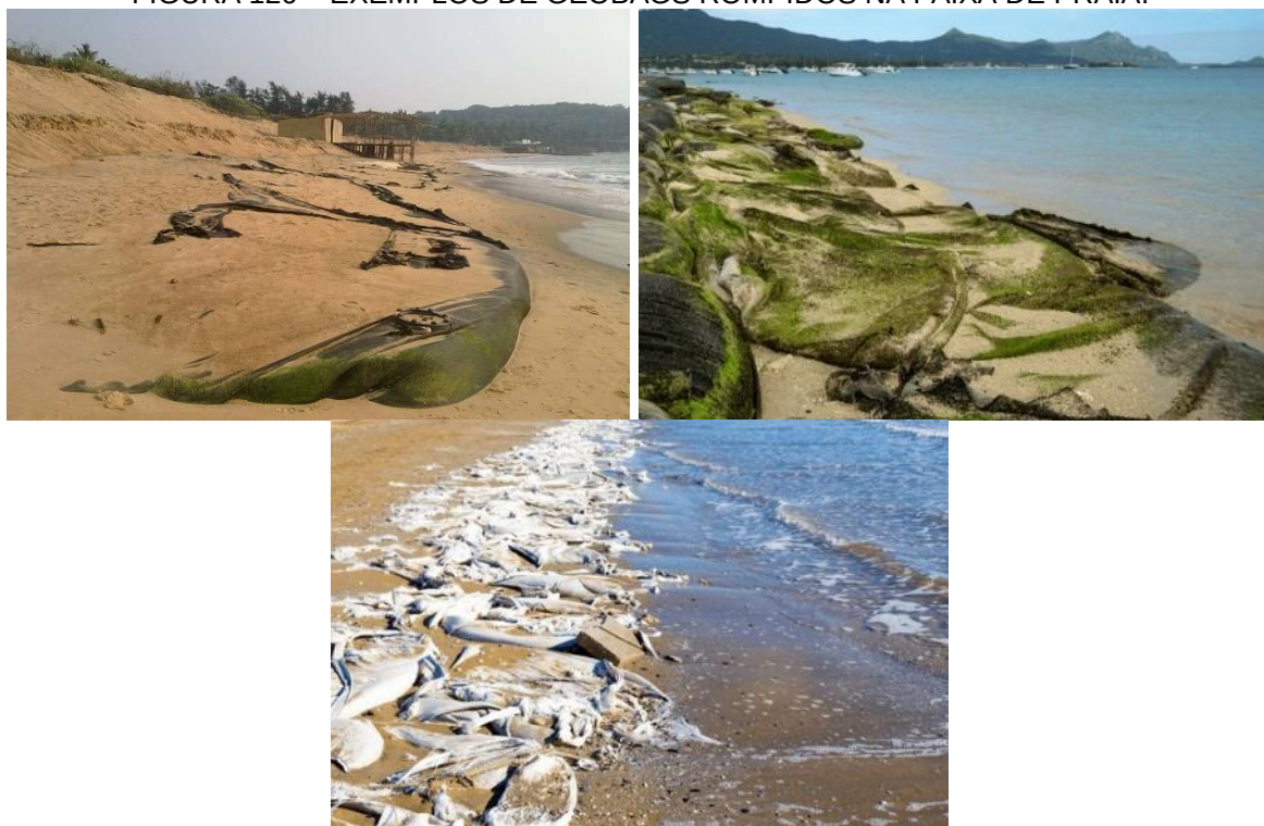
FIGURA 126 – EXEMPLOS DE GEOBAGS ROMPIDOS NA FAIXA DE PRAIA.
