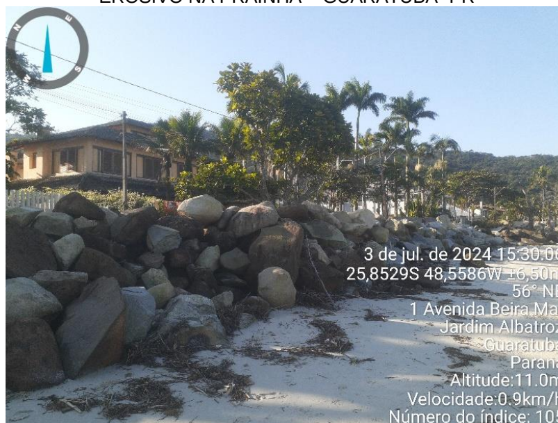
FIGURA 3 – BLOCOS ROCHOSOS UTILIZADOS PARA TENTAR CONTER O PROCESSO EROSIVO NA PRAINHA – GUARATUBA -PR
