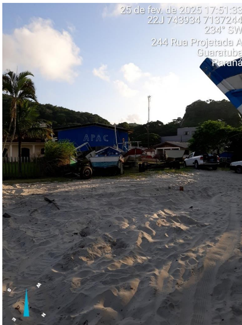
FIGURA 39 – BARRACÃO DA APAC
