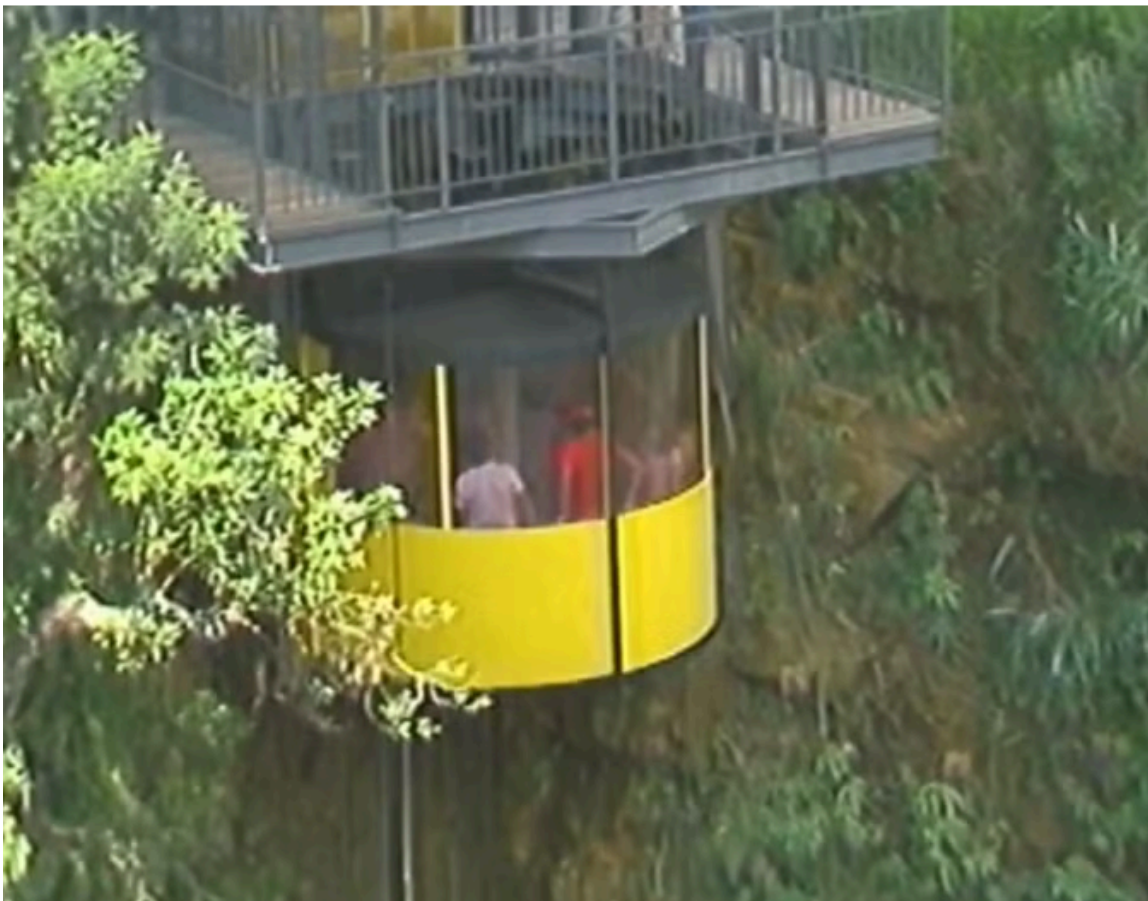
Figura 01 - Operação da antiga estrutura do Elevador Panorâmico da Furna I
