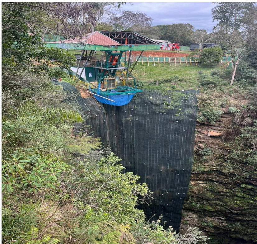
Figura 02 - Obra de revitalização do Elevador Panorâmico da Furna I
